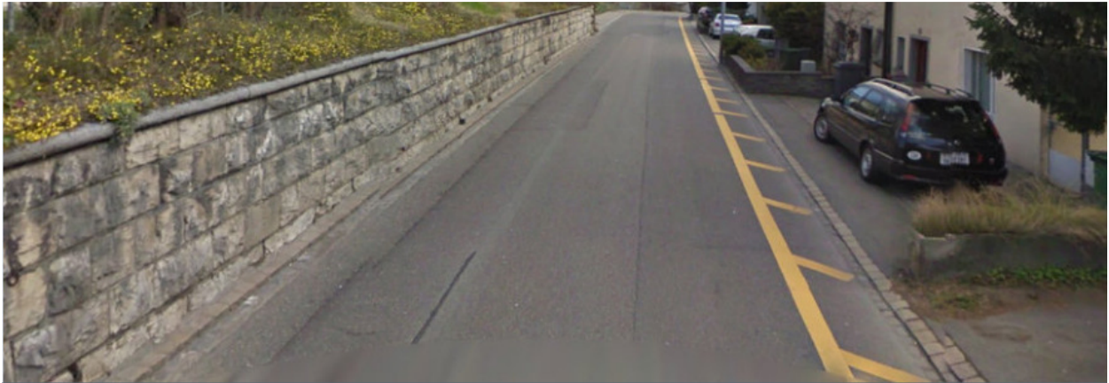
Am Wasser 109-119, 8049 Zürich
